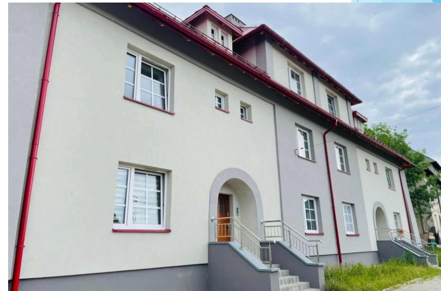
Zmodernizowany budynek na Osiedlu Wzgórze
