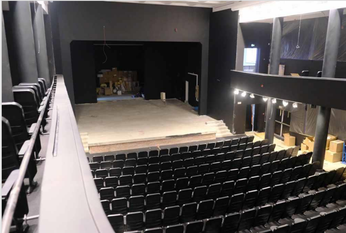
Zdjęcie 7. Remontowana sala kinowa w ramach zadania 9.
