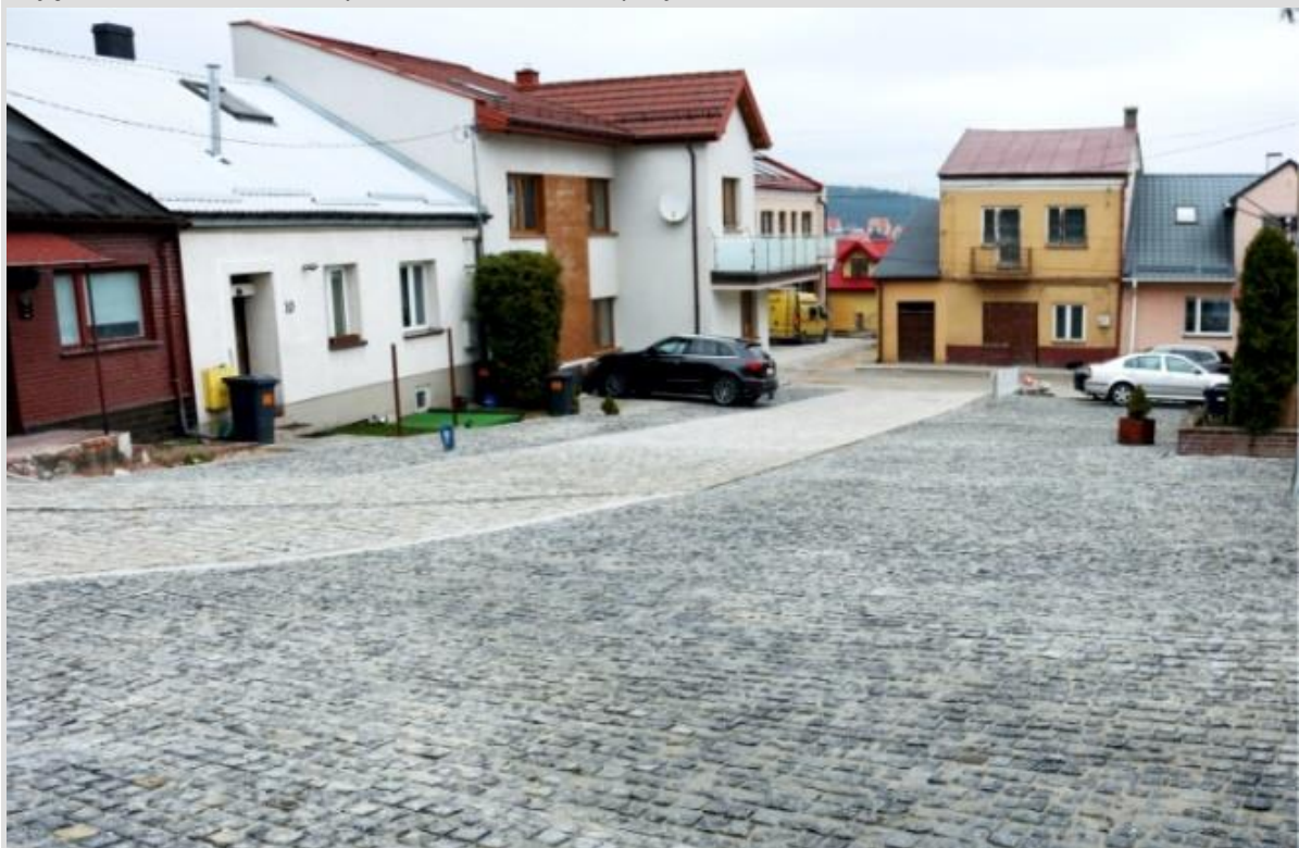
Zdjęcie 2: Nawierzchnia wymieniona w ramach projektu.
