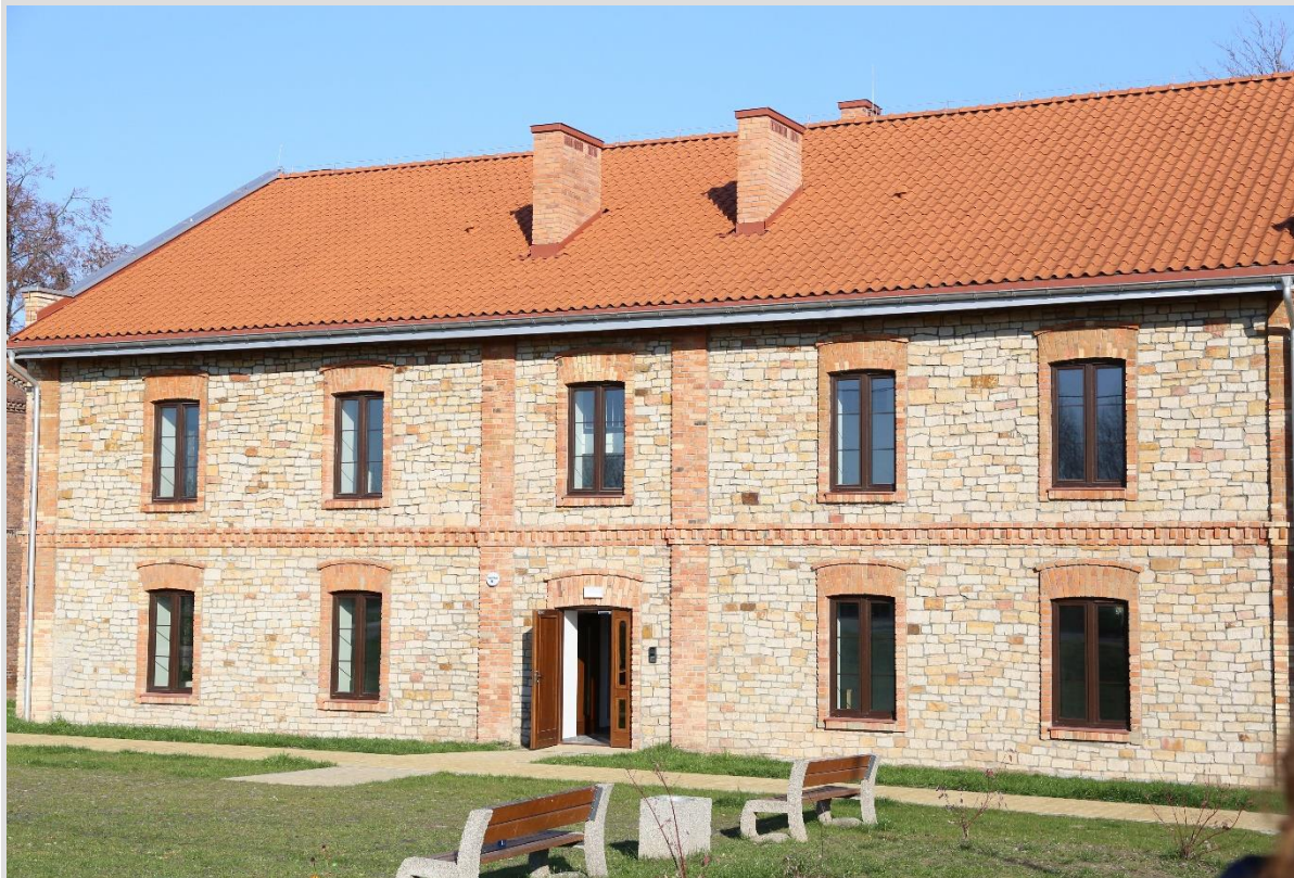
Zdjęcie 3. Budynek przy ul. Osadowej zmodernizowany w ramach zadania 5.
