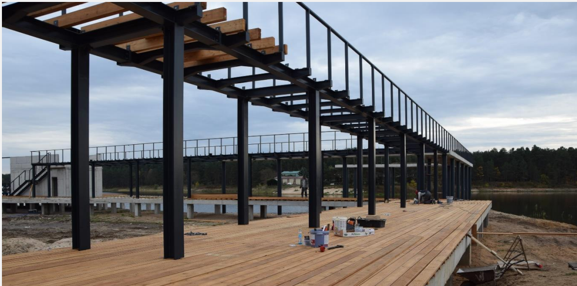
Zdjęcie 1. Pomosty budowane w ramach zadania 1.
